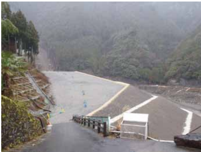
宇井地区復旧状況
