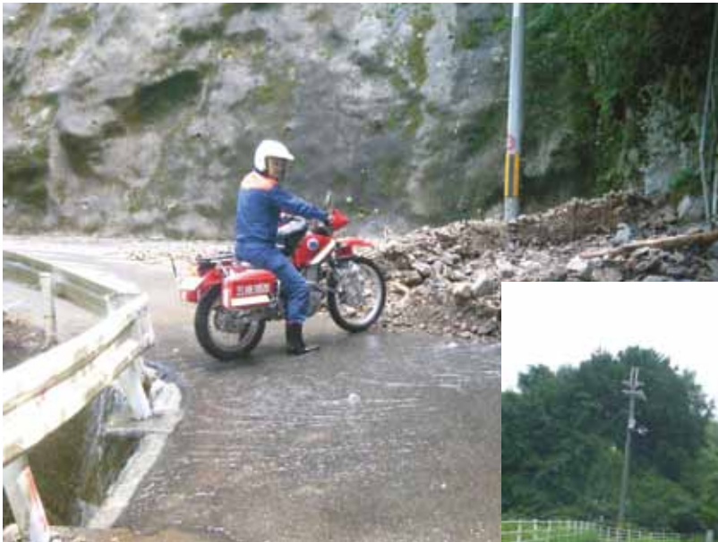
救急バイクによる被害状況調査
