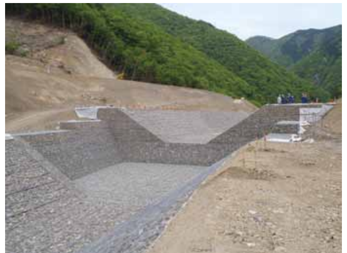
赤谷地区（上流）復旧状況
