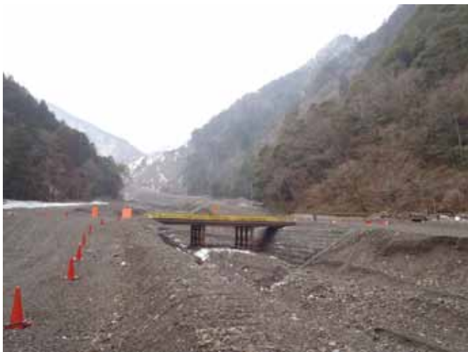
赤谷地区（下流）復旧状況
