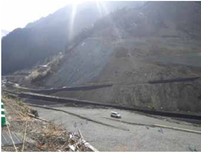
清水地区復旧状況
