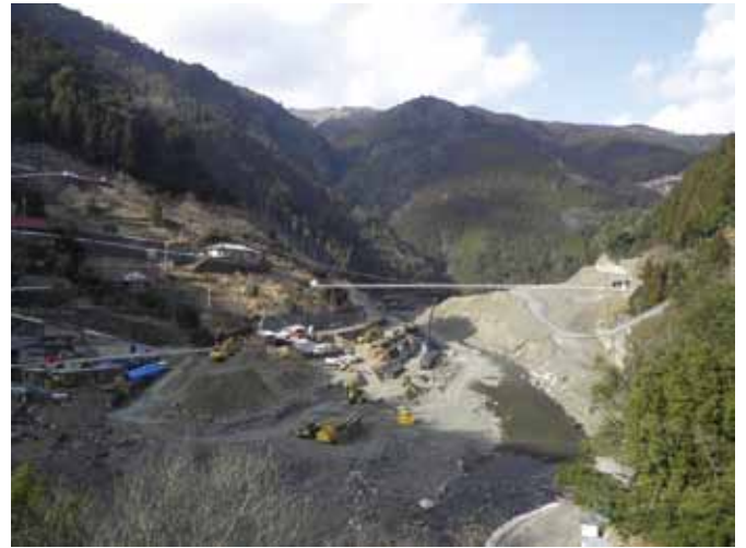
宇井・清水地区復旧状況（全景）
