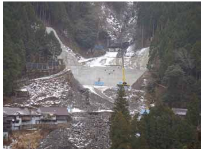
辻堂（鍛冶屋谷）地区復旧状況
