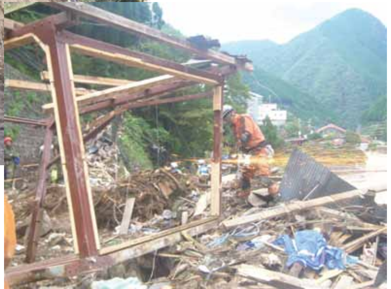
流出家屋撤去
