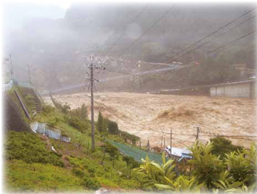
熊野川の氾濫状況
