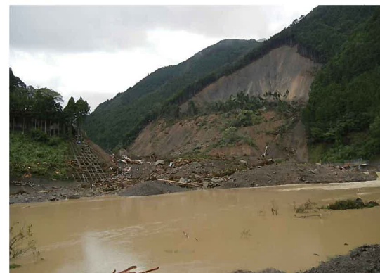
宇井地区の崩壊現場
