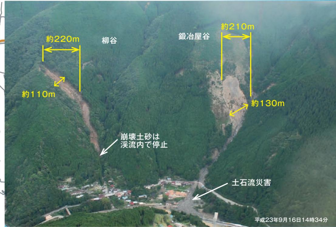
**3** 辻堂地区では、隣り合う柳谷・鍛冶屋谷で大規模な崩壊が発生しました。鍛冶屋谷の崩壊土砂は土石流化し、下流の人家・道路に被害を与え、一時、熊野川(十津川)を閉塞しました。
