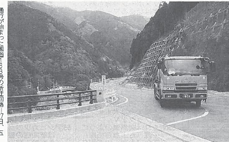
通行が始まった国道168号の新迂回路(27日、五條市大塔町内)
