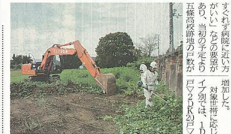
緊急仮設住宅の建設工事が始まった旧五條高校跡地＝30日、五條市岡口1丁目
