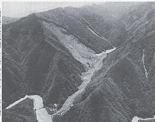
五條市大塔町赤谷付野土砂ダム。左下が下流。C2（国土交通省近畿地方整備局提供）
