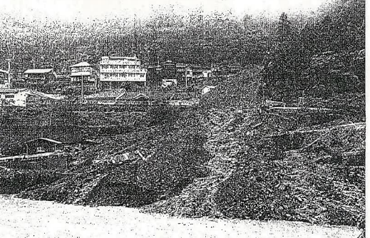
大規模に崩落した斜面＝4日、五條市大橋町建設
