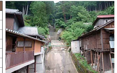
平成24年8月11日 崩壊地の谷の出口 治山ダム(谷止工、床固工)が設置されている。
