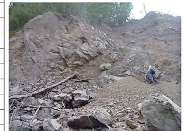
平成24年5月23日 (旧)崩壊による土塊と剪断帯 崩積土に含まれる移動土塊の下部に 厚さ1.4mの剪断組織が見られる。 (旧)崩壊のすべり面に相当。 すべり面は【N70W、46N】の走向・傾斜を示す。
