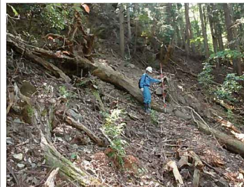
平成24年5月23日 滑降崖下の崩積土状況 砂岩、泥岩岩屑を多く含む礫混り土
