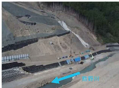
平成25年10月18日撮影 (河川堆積土砂暫定掘削完了)
