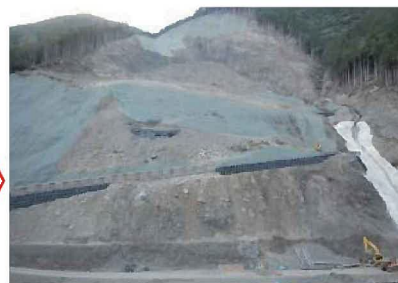
平成25年10月21日撮影 (斜面对策状況)
