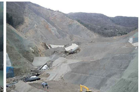
平成26年3月25日撮影 (赤谷の施工状況)
