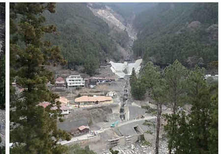
平成26年3月25日撮影 (鍛冶屋谷の施工状況)
