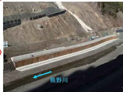
平成26年1月24日撮影 (台風18号被災仮設護岸復旧完了)
