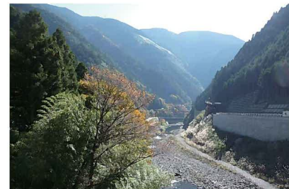
被災前、新辻堂橋より堂平橋方向
