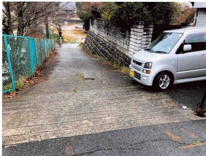
敷地東方通路部
