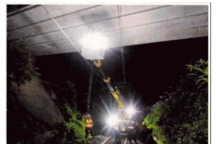
▲ 橋梁点検の様子
