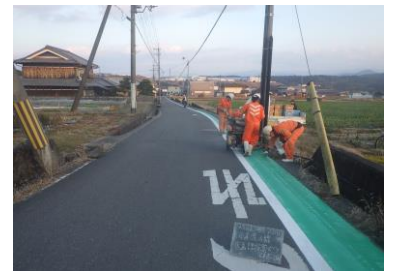
▲ 安全対策舗装工事
