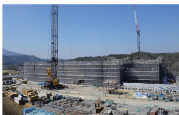
(病院建設現場※平成27年3月撮影)
