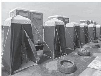
マンホールトイレ (国土交通省ホームページより転載)
