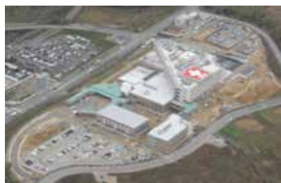
(病院建設現場※平成27年12月)
