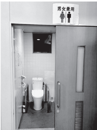
3月22日に設置された便器
