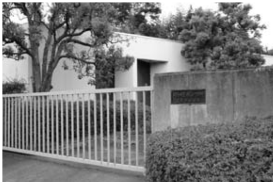
岡加圧ポンプ所
