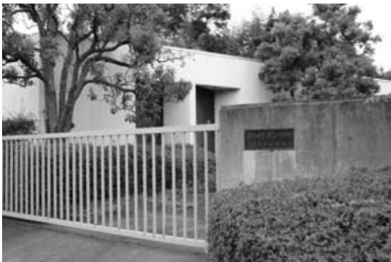
岡加圧ポンプ所
