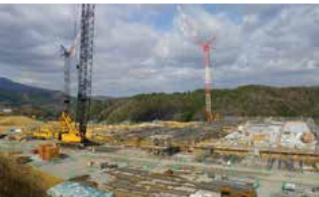
(病院建設現場※平成26年12月撮影)
