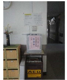
学校に設置 された応急箱
