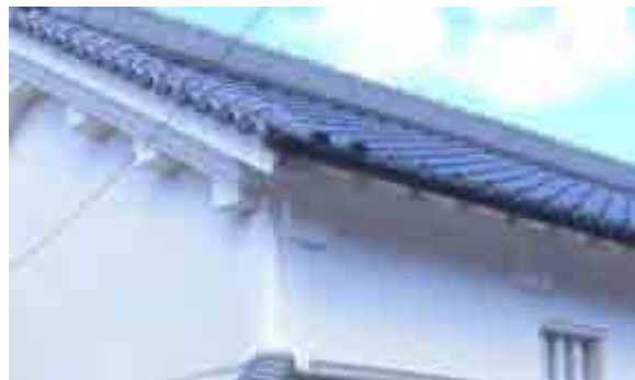
補修された大壁、軒裏の塗込
