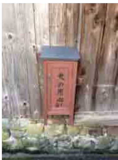
屋外消火器の設置 (五個荘地区)
