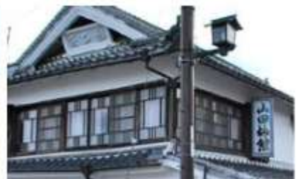
●連続窓（ガラス窓）
