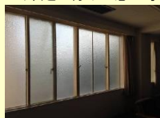
建て付けが悪く開かない窓
