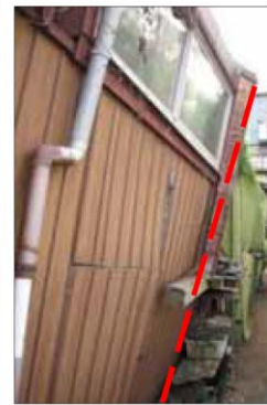
柱の変形が著しく崩壊の危険がある例（100点）
