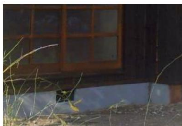
コンクリート基礎等 (評点 0)
