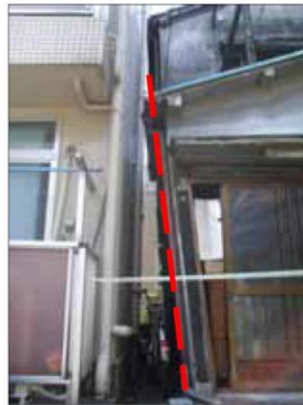
柱の変形が著しく崩壊の危険がある例（100点）
