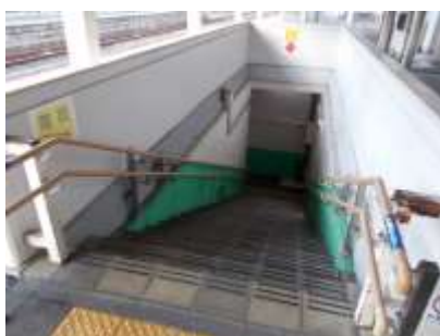
(2) 地下連絡通路
