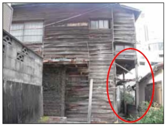
柱に局所的な亀裂やひび割れ等がある例 (柱、はり、筋かい、柱とはりの接合等)
