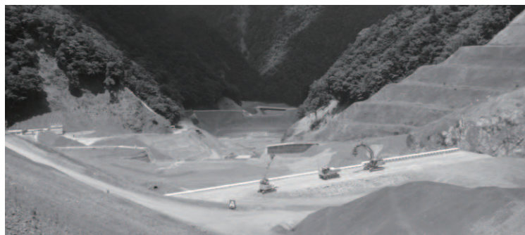
3号砂防堰堤（令和3年7月28日撮影）
