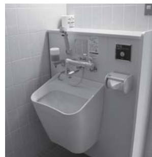
市役所別館前の オストメイト対応トイレ
