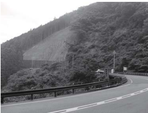
片側交互通行で復旧した箇所
