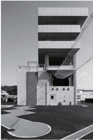
5階建ての訓練塔
