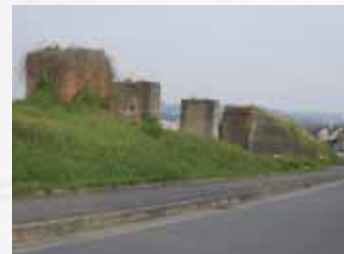
～今も残る川端線の橋脚～ 二見5丁目
