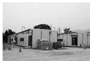
岡口の仮設住宅
