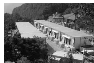
阪本の仮設住宅
