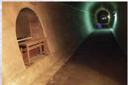
天辻トンネルの内部
