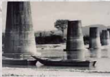
吉野川に建てられていた橋脚 (撮影時期不明)
