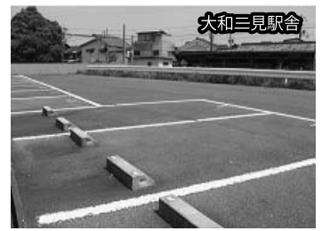
二見駅前北側駐車場
