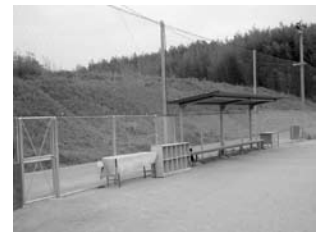
コミュニティ助成事業でフェンス設置
