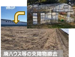
【荒廃農地の支障物撤去】
