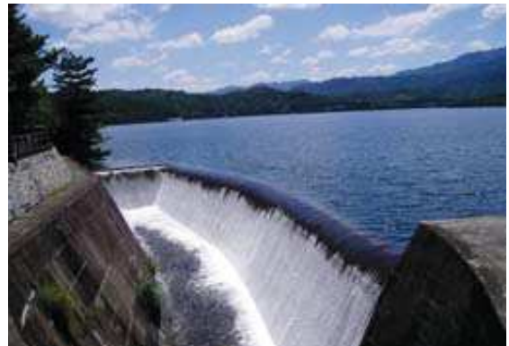
写真2：洪水吐 (香川県HPより)
