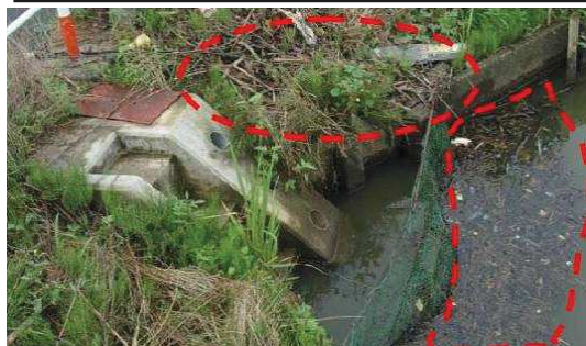
写真 38：取水部周辺の土砂やゴミの堆積
