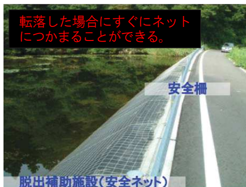
写真15：安全ネットの設置
