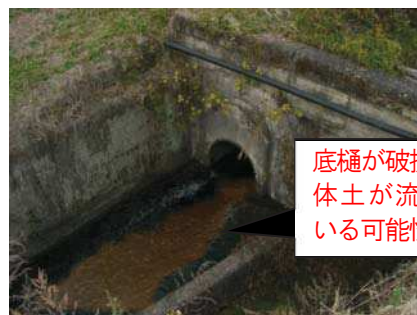
写真11：底樋出口（堤体下流）
