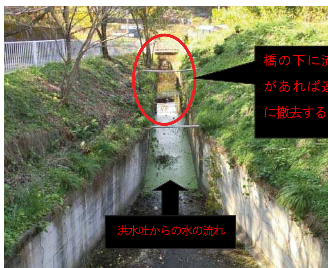
写真8：洪水吐下流水路の例
