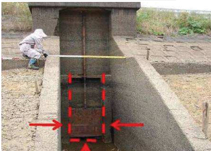
写真 37：ゲート周りの漏水
