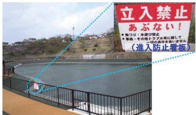
写真14：安全柵の設置
