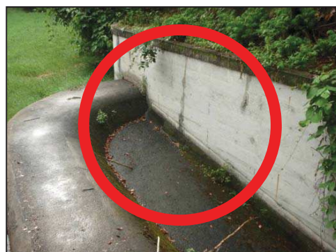
写真9：洪水吐流入部
