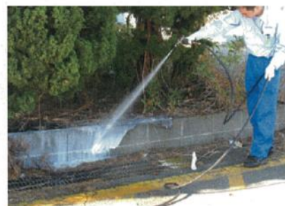
専門業者による液剤の高圧散布
