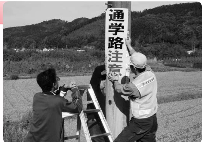
交通安全を願って標識を設置する
