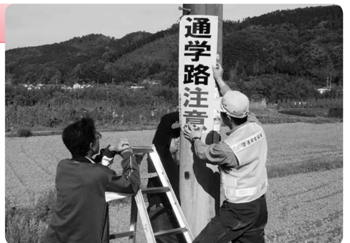
交通安全を願って標識を設置する
