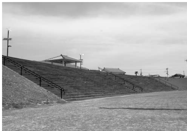
木製階段デッキ
