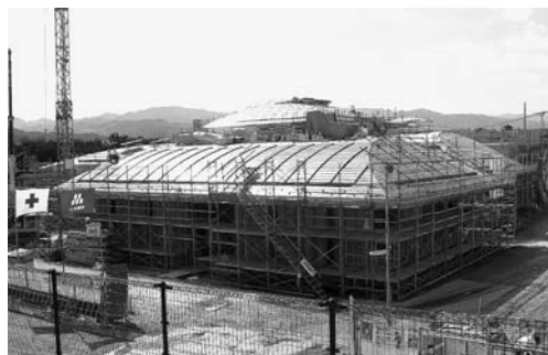
火葬場建設事業
