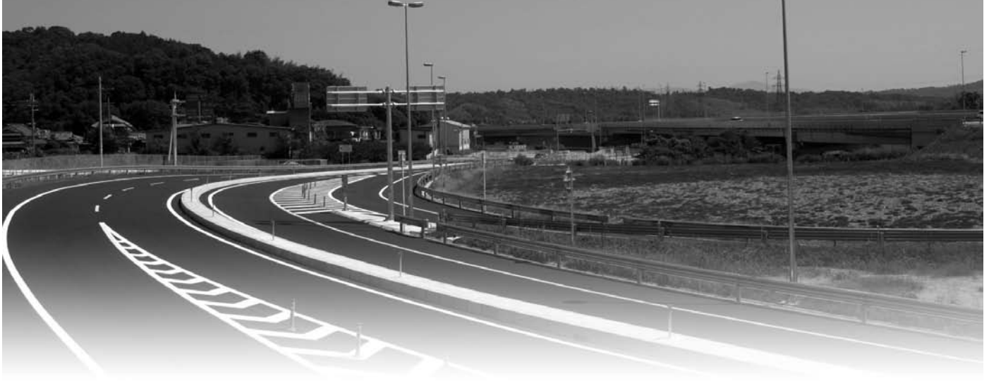
京奈和自動車道五條インターチェンジ
