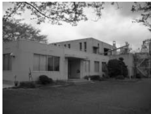
衛生センター
